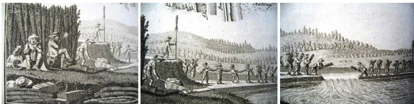
The Construction of Fascines in Prussia in the 18 th Century. Source: All three images are clips from a single image in H.C. Riedel, jun. Riedel, H. C., jun., “Über unvorhergesehene Unfälle bey Coupirung der Deich Durchbrüche,” Sammlung nützlicher Aufsätze und Nachrichten die Baukunst betreffend Bd. 3.1 (1799): 24-53, Table II. Images from Olesko (2010), courtesy of Kathryn M. Olesko, Department of History, Georgetown University.
